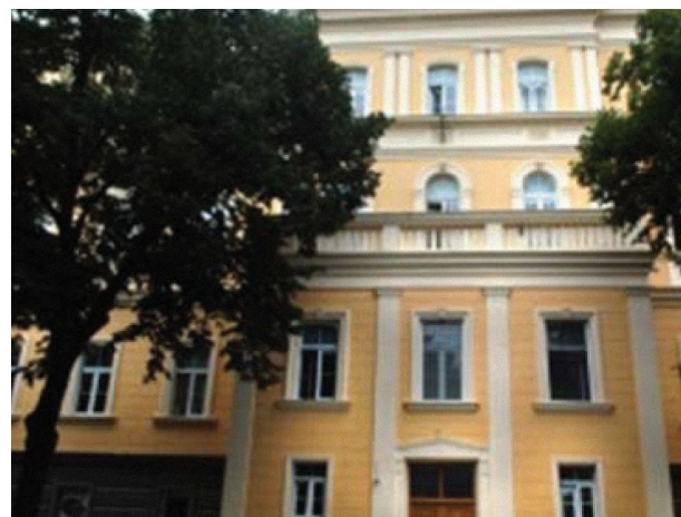
Slika 2. Renovirana fasada stare zgrade u Vrtlarskoj
